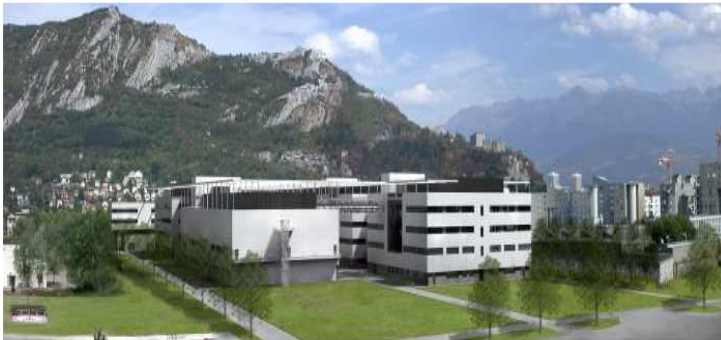
Prime contractor : Conseil Général de l'Isère - Représentative : Territoire 38 - Contracting Authority : Groupe 6, Setec Industrie, Faure Ingénierie et Adret
